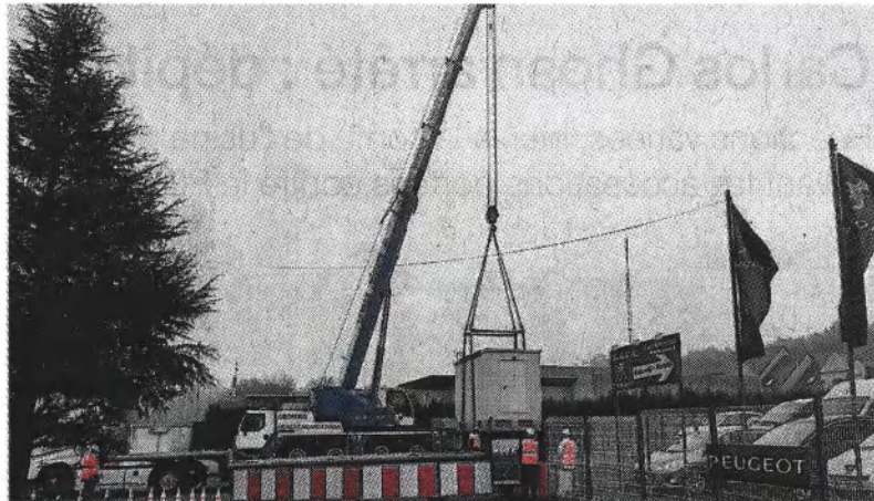
La pose du nœud de raccordement optique à Saint-Florent-le-Vieil, le 16 novembre
