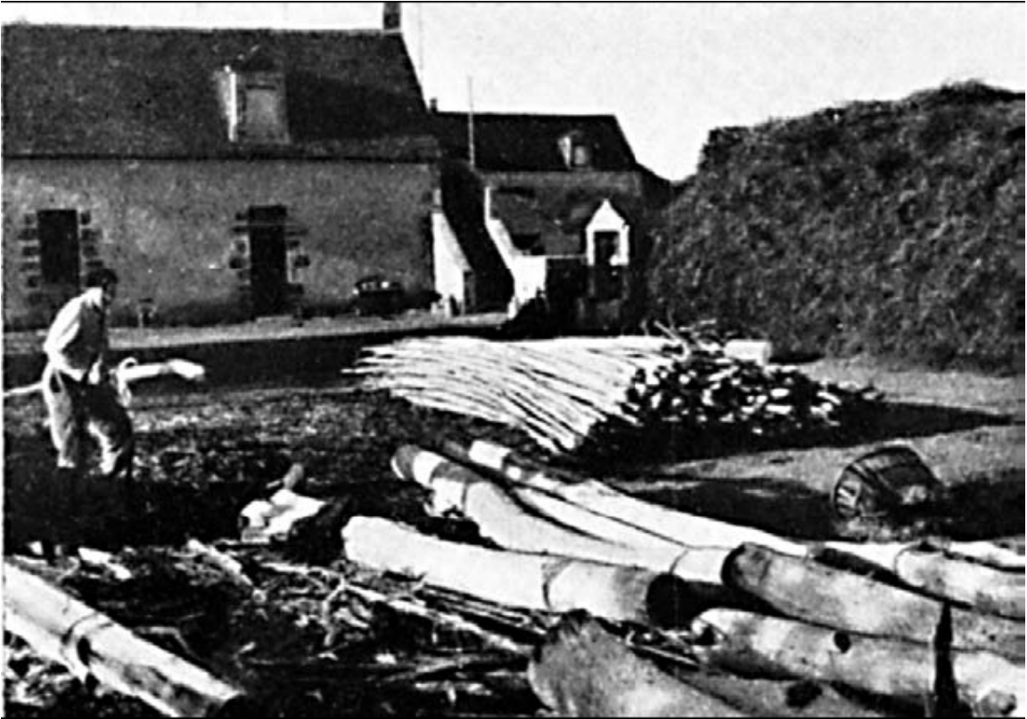
Matériaux pour la construction d'une loge près de Beaufort en Vallée.
